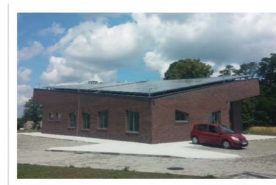
Budynek ośrodka zdrowia
